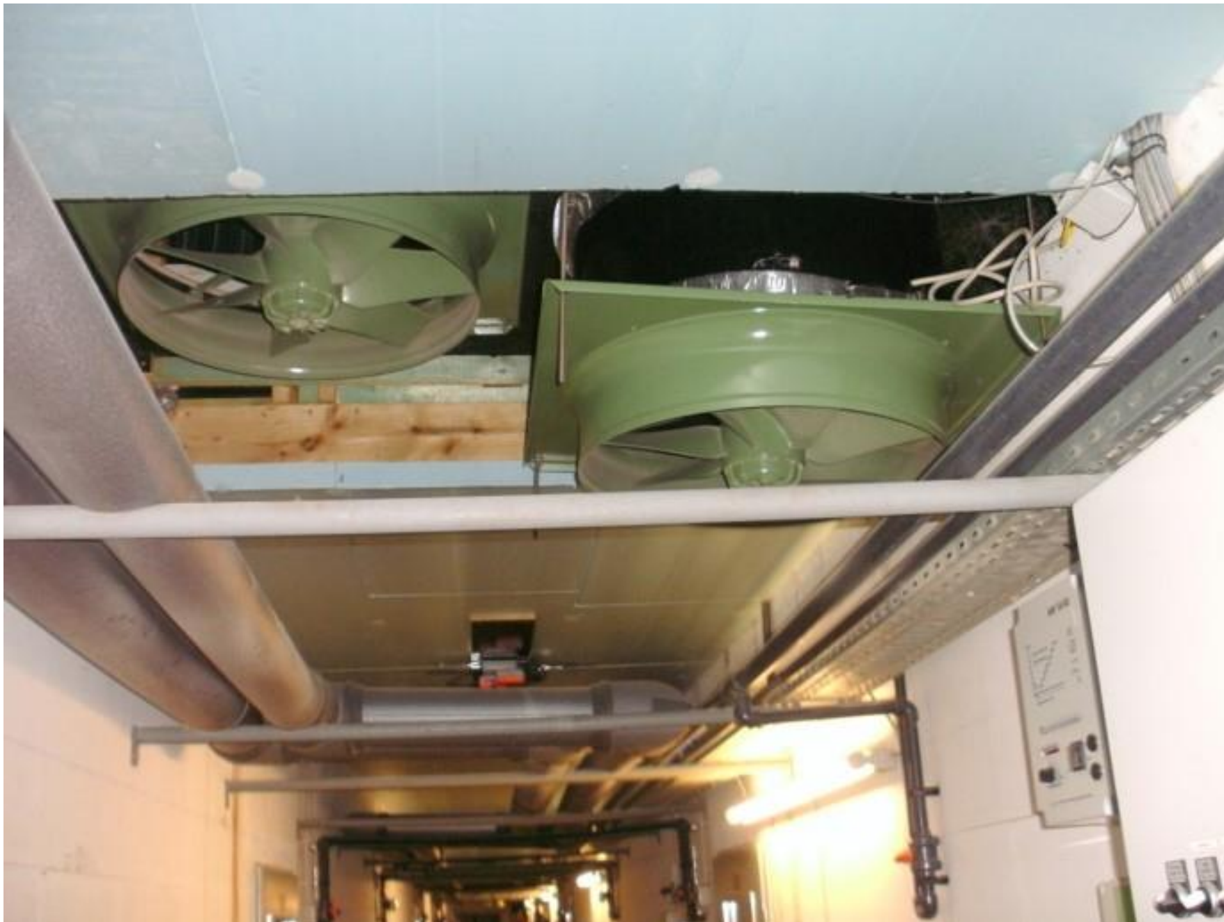
Wärmetauscher Gang Ferkelaufzucht
