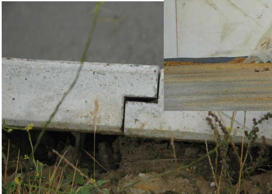
Stufenfalz mit Dichtband
