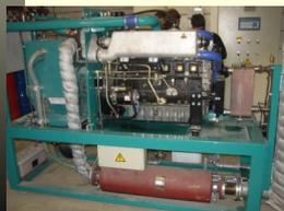
Mit dem **BHKW** (**B**lock**h**eiz**k**raft**w**erk) wird aus Biogas (Methan) Strom und Wärme erzeugt.
