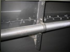
Durch die **Heizrohre** wird die Biomasse auf die für die Gärung nötige Temperatur (ca. 38 - 40°C) erwärmt.
